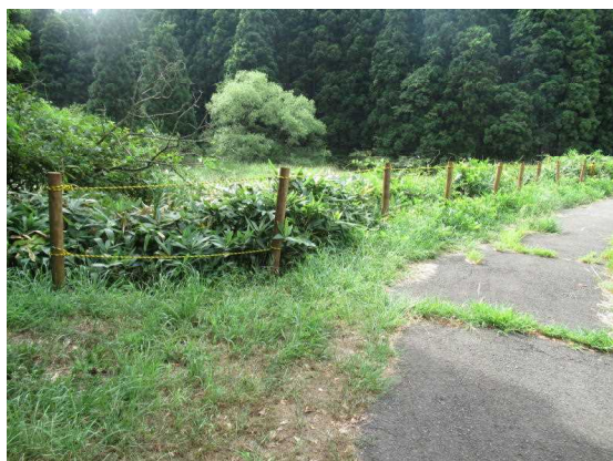
転落防止の木製柵を補修
